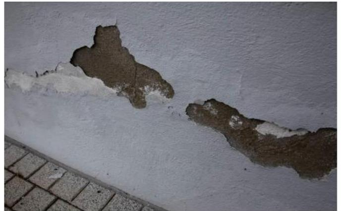
**Feuchtschäden an der Ostseite der Fassade.**
